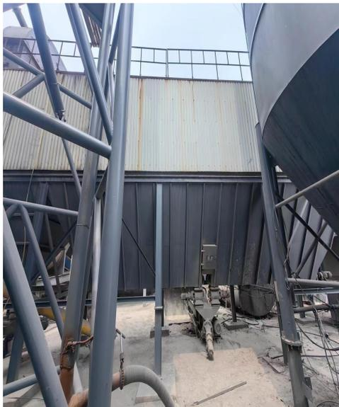
冷料上料、烘干工序除尘器
