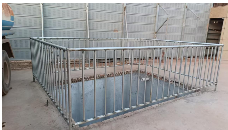
初期雨水收集池
